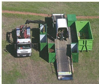
Une déchèterie mobile, rapidement installée et déplacée.
